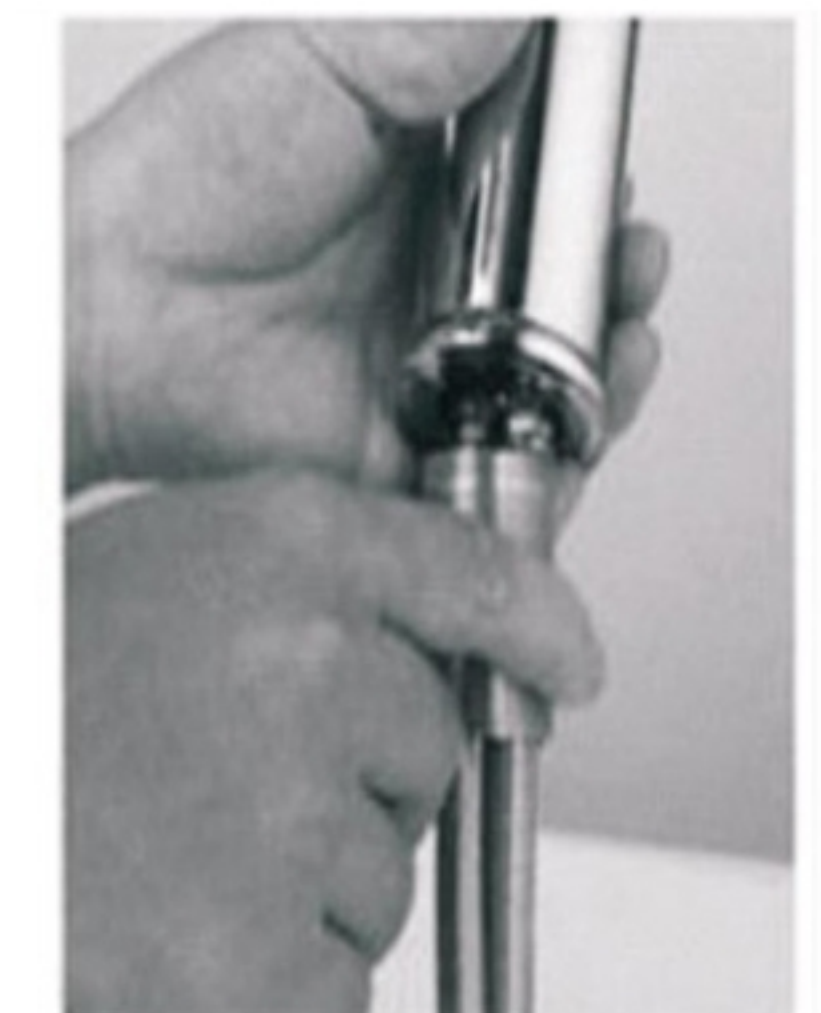
3, Tigten the lap and back nut
